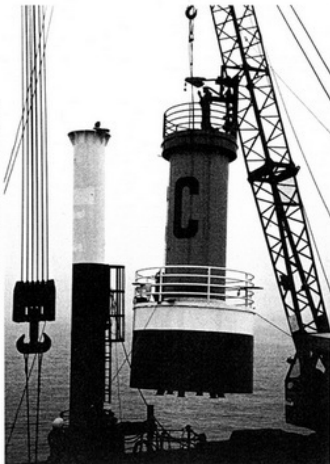
Bake C, Aufsetzen des Bakenkopfes mit Aufsatzteil
