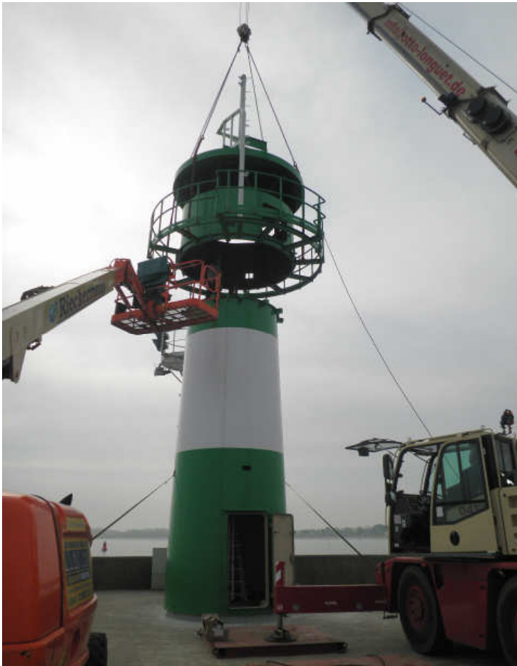
Abb. 6: Montage des Laternengeschosses
