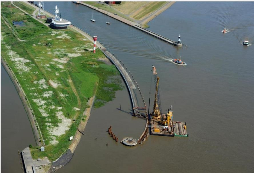
Der Standort des Leuchtfuers Mole wird gegenüber dem bisherigen Standort um ca. 50 m in Richtung Westen verschoben. Zu diesem Zweck wird der vorhandene Molenkopf auf einer Länge von ca. 25 m abgebrochen und ein ca. 75 m langes Molenbauwerk errichtet.
