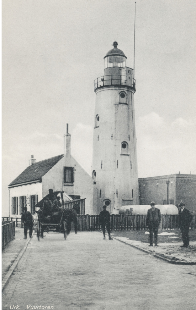
De vuurtoren eind jaren '30. De betonnen platen met patrijspoorten in de raamopeningen zijn in 1934 aangebracht.
