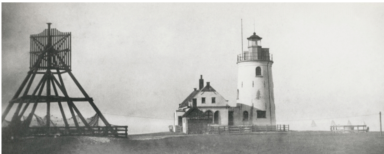
De vuurtoren in 1900. Een jaar later is de gemetselde torenschacht met ruim vijf meter verhoogd en is er een nieuw lichthuis geplaatst. De kaap is in 1923 afgebroken.
