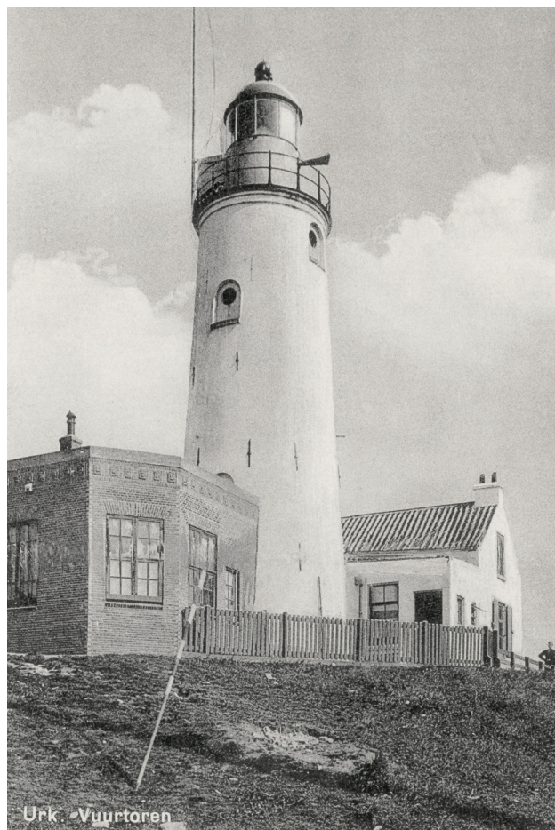
De vuurtoren in de jaren '30. De misthoorn is duidelijk zichtbaar. De perslucht hiervoor wordt geproduceerd in de machinekamer.
